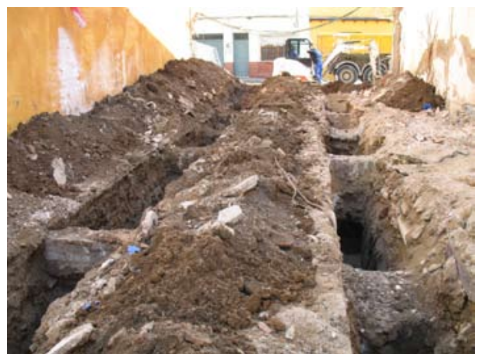
Lámina II. Zanjas nº 1 y 2
