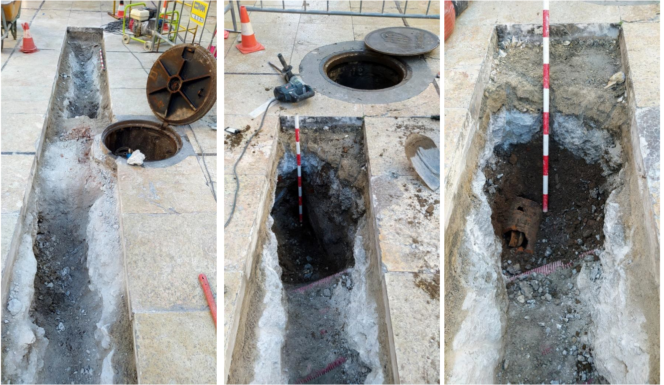
Ilustración 12: Tramo sur de la Zanja 1, donde se ha profundizado hasta la caseta subterránea.
