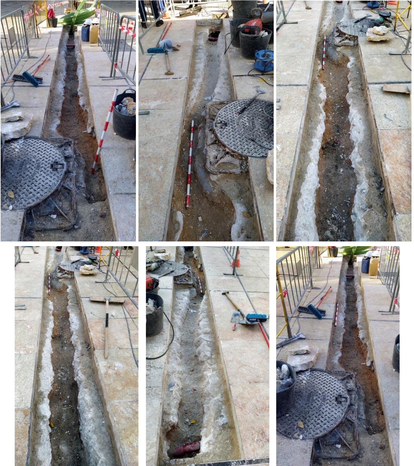
Ilustración 20: Partes del segundo tramo de la zanja 1.
