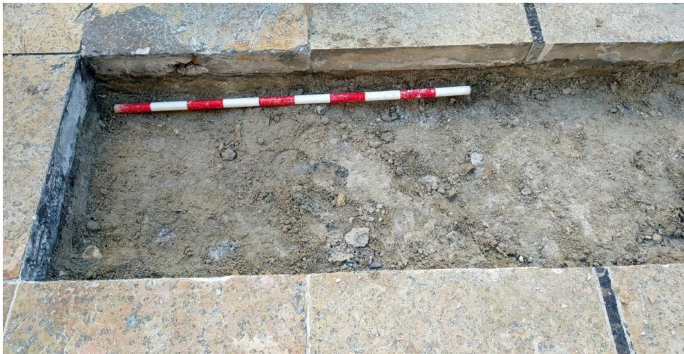
Ilustración 8: Capa de tierra y cemento mezclada, como base de las losas.
