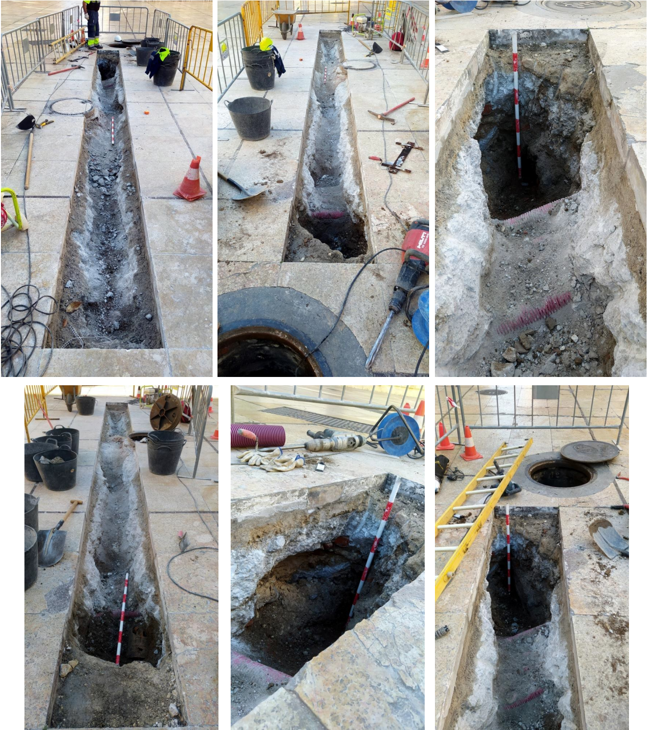
Ilustración 11: Tramo sur de la Zanja 1. Punto más profundo del rebaje.
