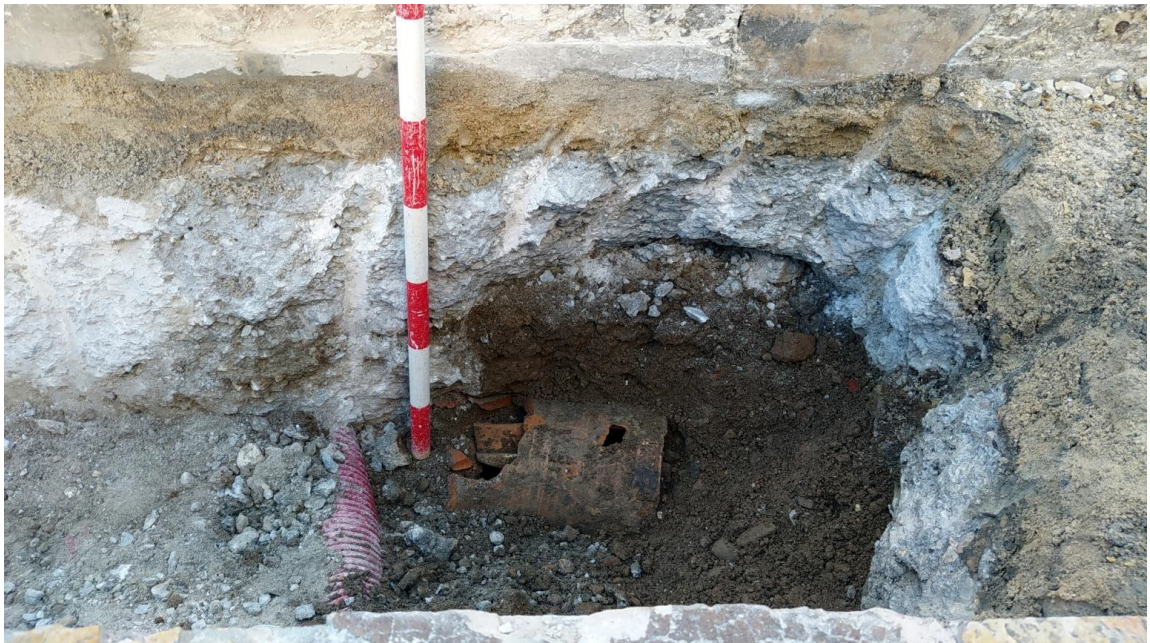
Ilustración 13: Fragmento de la tubería de atadores bajo la conducción de electricidad.
