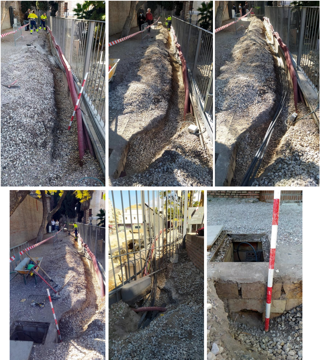
Ilustración 17: Zanja 2 y arqueta de enlace.
