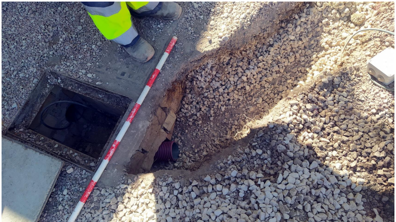
Ilustración 18: Zanja 2, el relleno de grava gruesa.
