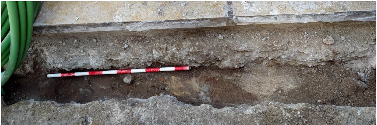
Ilustración 21: Piedras y ladrillo trabados con mezcla de tierra y arena, entibe de los atadores.
