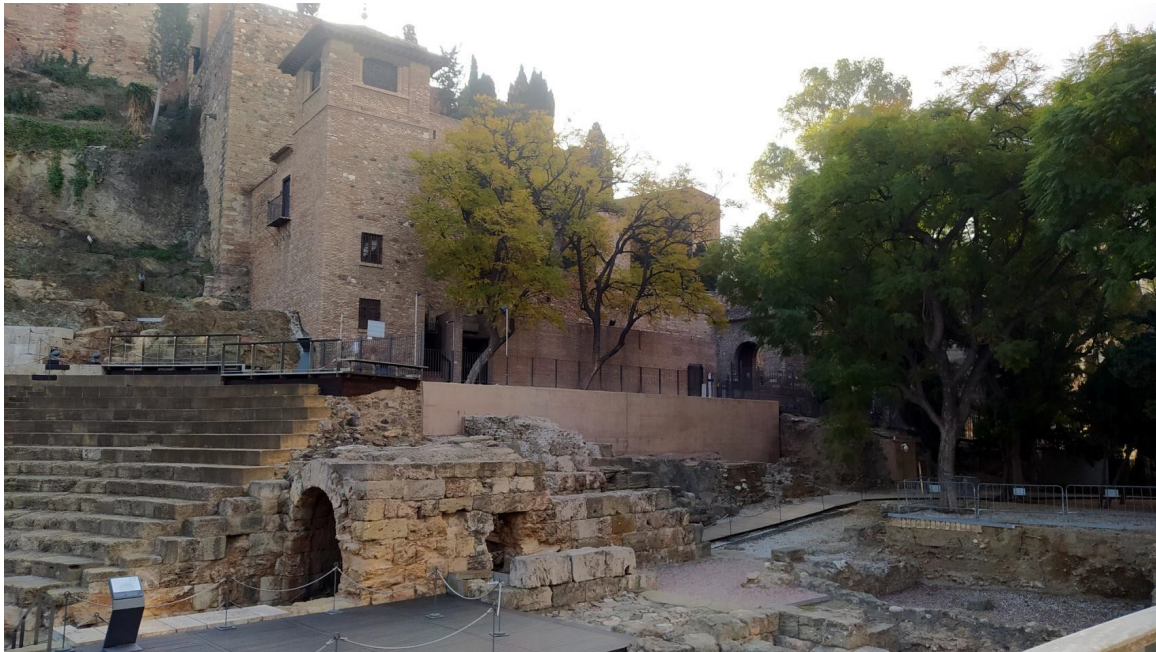
Ilustración 15: Vista exterior del emplazamiento de la obra
