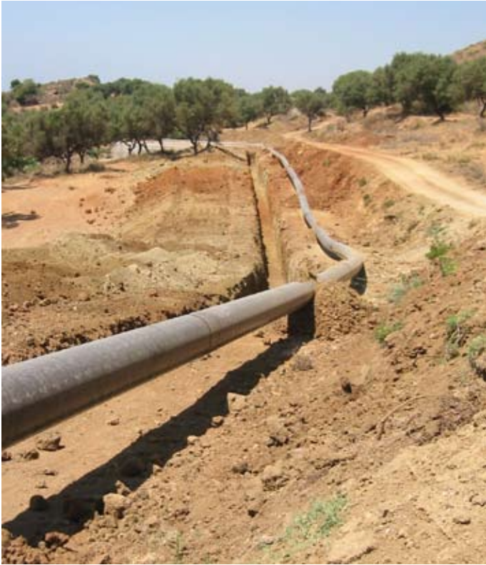
Lámina I. Vista del inicio del proyecto. Zona de enlace con posición S-06.3 de ENAGAS (en construcción)
