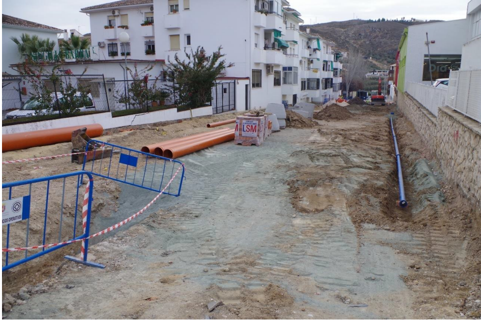
Fig. 1. Desarrollo de los trabajos, con la apertura de zanjas (a la derecha) para la inserción de redes de abastecimiento.
