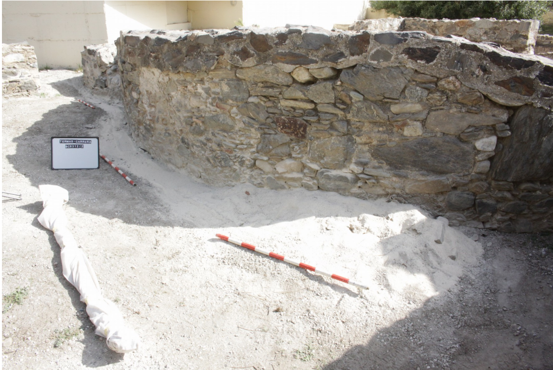
Figura nº 2: Detalle de la cubrición y cierre del sondeo.
