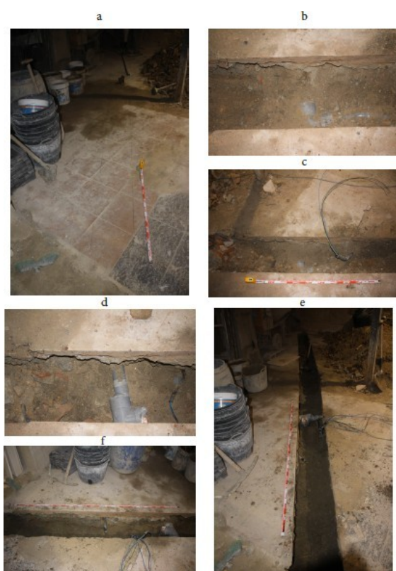
Fig. 6: a) vista general de la zanja a su inicio; b) detalle de canalización de PVC; c) detalle de cableado; d), e) y f) detalle y vista general de la zanja a su finalización.
