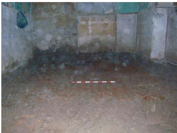
Lámina I. Área 2.000 – Pavimento U.E.E. 4.
