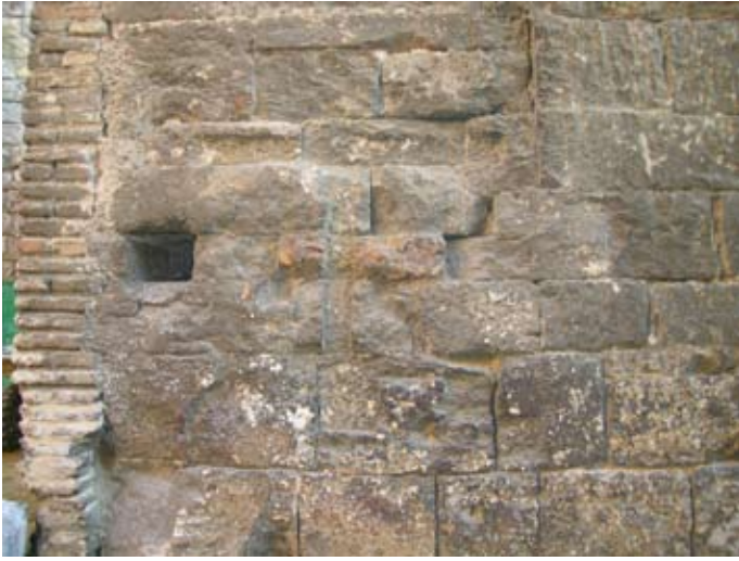
Lámina VIII. Detalle de la impronta del cerrojo y otros elementos de la puerta bajomedieval perdida.
