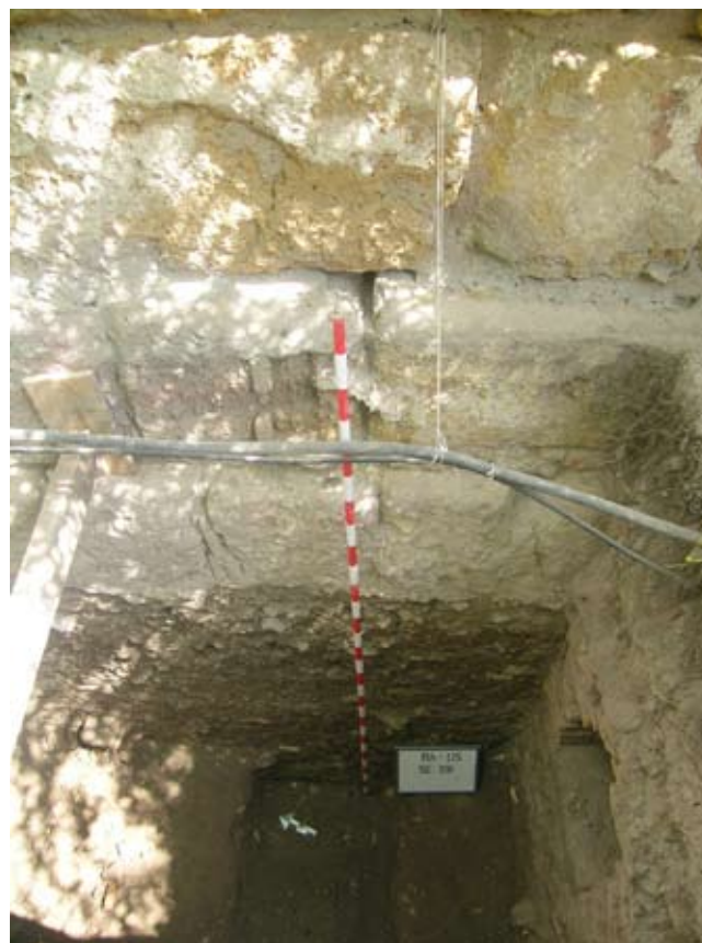
Lámina V. Sondeo SE XIII. Detalle de la zanja de cimentación donde se asienta la muralla del alcázar (ue. 1406).
