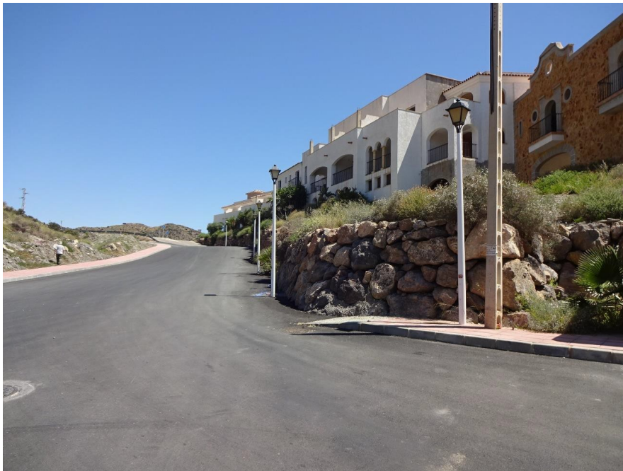
Trazado principal de la línea soterrada en El Calón
