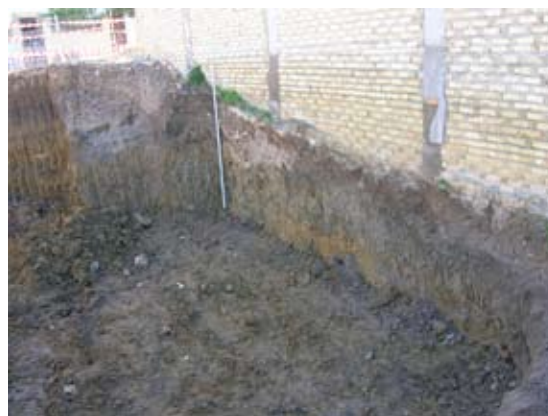
Lámina III. Vista del Perfil Oeste.
