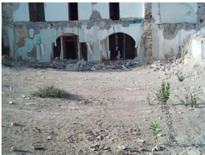
Lámina VII. Parte posterior de la primera crujía
