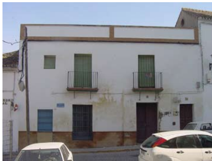
Lámina I. Fachada antes de la ejecución de las obras proyectadas
