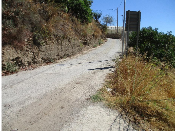
Camino por donde discurrirá el futuro colector hacia la EDAR
