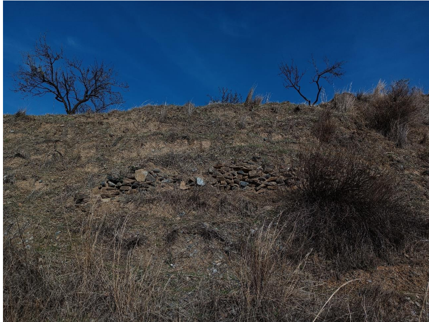
Detalle de alguna de las estructuras de contención documentadas
