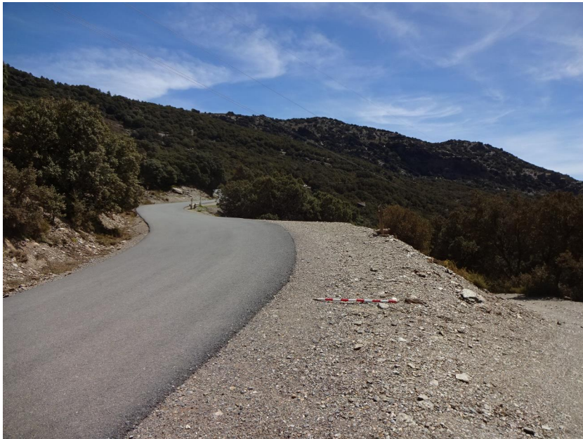
Panorámica general de la carretera junto a la que se prevé el soterrado
