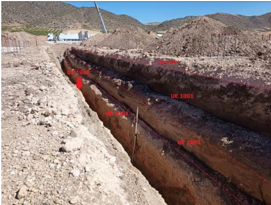
7.Estratigrafía de la zanja de evacuación de purines
