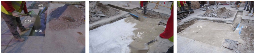
Fig. 12. Imágenes del proceso de cubrición de la estructura 2. 2018. Elaboración propia.
