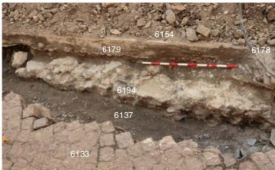
Fig. 06. E-2 construida a base de cantos rodados unidos con mortero de cal. 2018. Elaboración propia.
