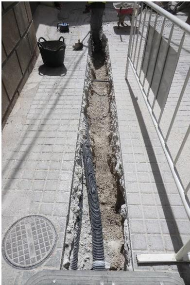
Foto 5. Vista de zanja con acometidas anteriores en C/ Oscura
