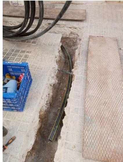
Foto 6. Detalle de tubería de gas natural en C/ Oscura
