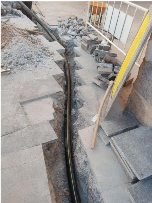
**Foto 10.** Detalle de incursión de tubería de gas natural en C/ Almendro
