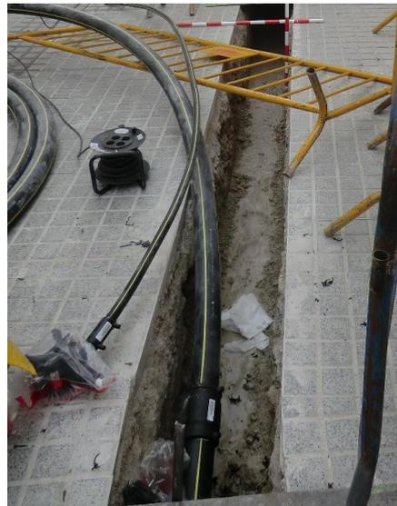
**Foto 15.** Detalle de incursión de tubería de gas natural en C/ Monjas
