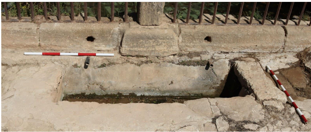
Figura 14. Detalle de diversos orificios y caños de salida de agua desde Fuente Santa al CE 004
