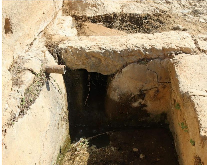
Figura. 15. Detalle de entrada de agua UE 017 (E 003)
