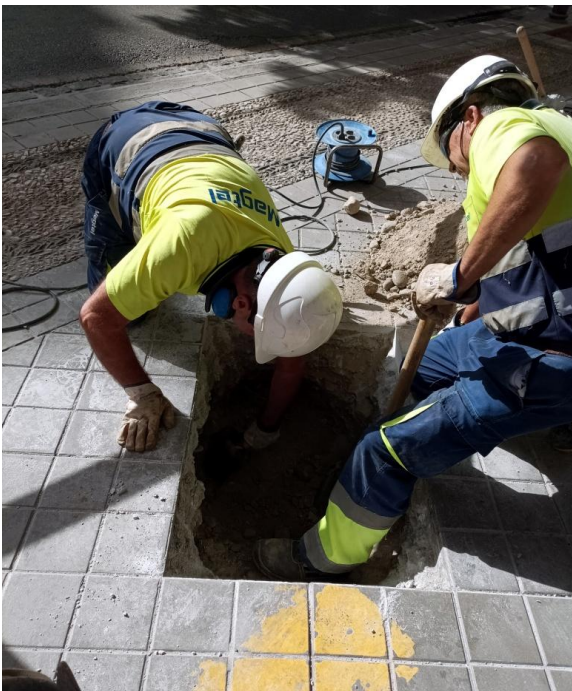
Ilustración 6: Relleno a base de arena y tierra, para cubrir los servicios soterrados.
