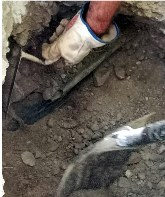
Ilustración 6: Relleno a base de arena y tierra, para cubrir los servicios soterrados.
