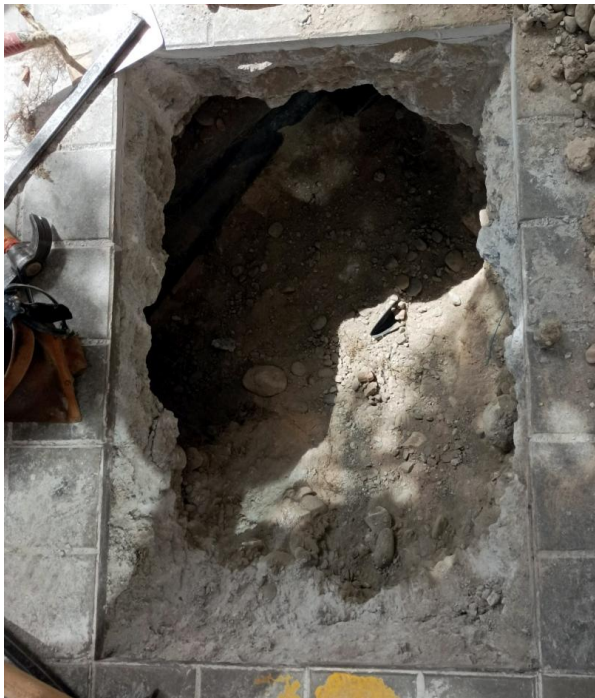
Ilustración 8: Final de la excavación a -60cm de profundidad.
