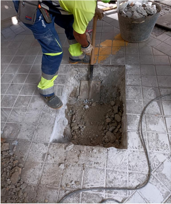
Ilustración 6: Relleno a base de arena y tierra, para cubrir los servicios soterrados.
