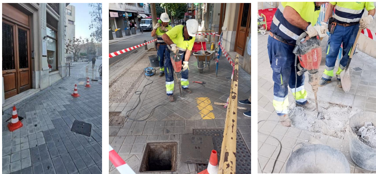
Ilustración 5: Planteamiento de la Cata para localizar la obstrucción.
