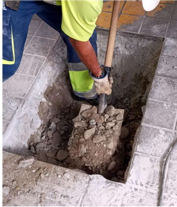
Ilustración 6: Relleno a base de arena y tierra, para cubrir los servicios soterrados.
