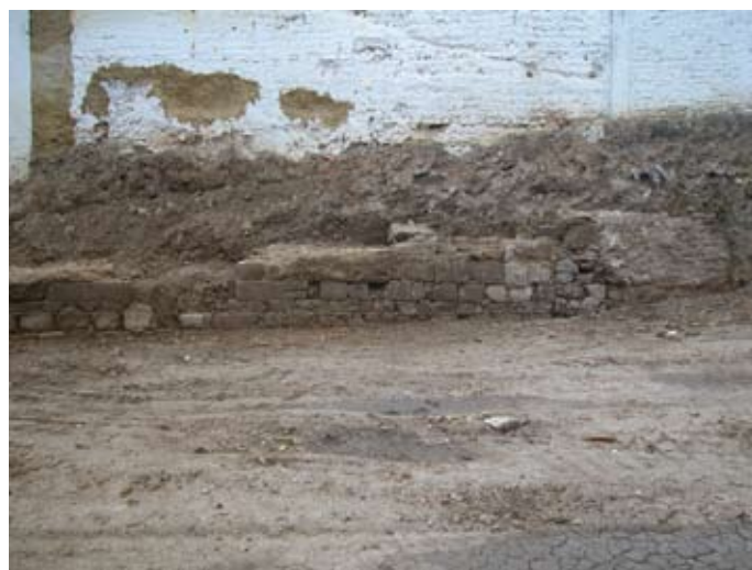
Lámina I. Vista frontal de la fachada occidental con las dos fases constructivas.
