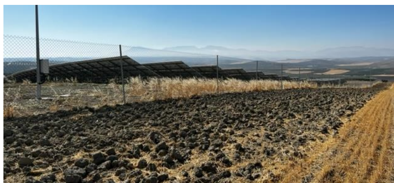
Fig. 5. Instalación fotovoltaica construida en la parcela contigua en 2020.
