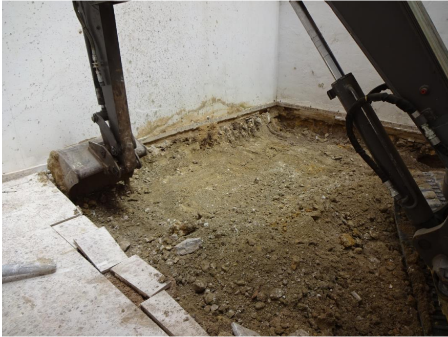
Limpieza hasta cota de afección, con el afloramiento de las arcillas geológicas
