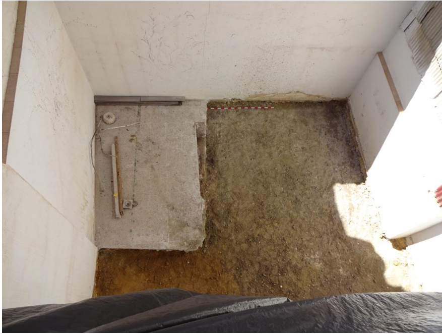
Foto cenital general una vez finalizada la intervención
