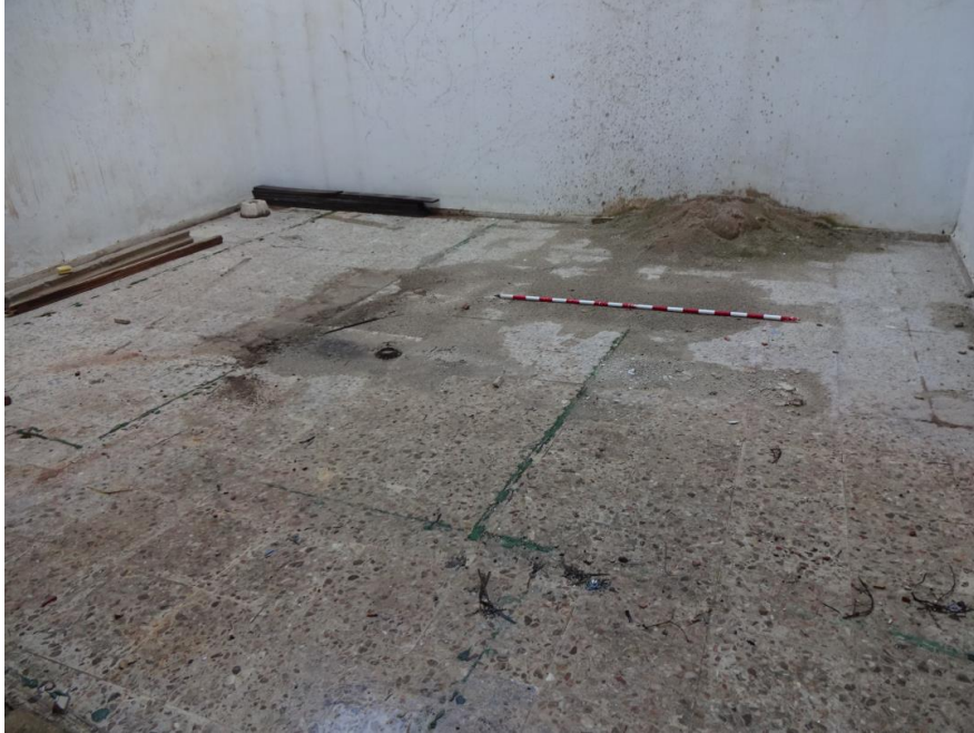
Estado previo del patio
