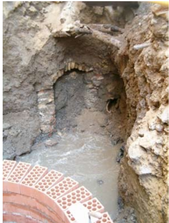
Lámina III. Sistema de canalización subterránea, alcantarillado público, del S. XVIII.
