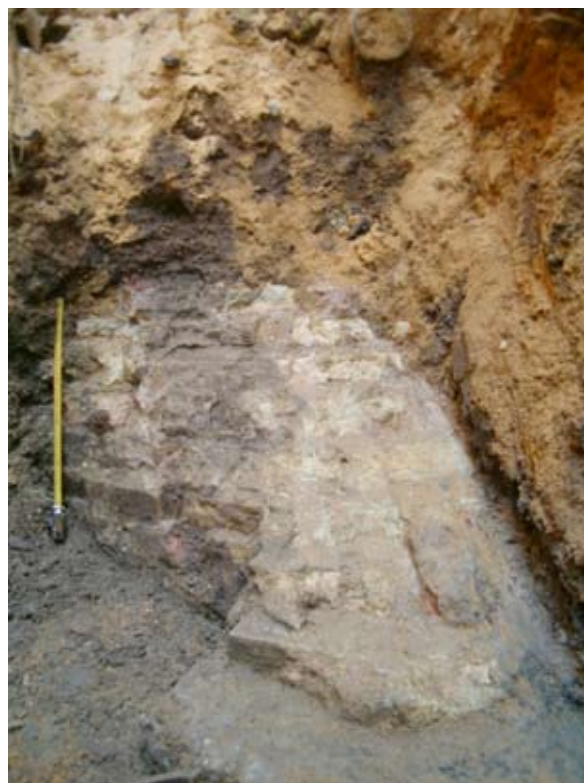
Lámina X. Vista de un tramo del muro U.E.198
