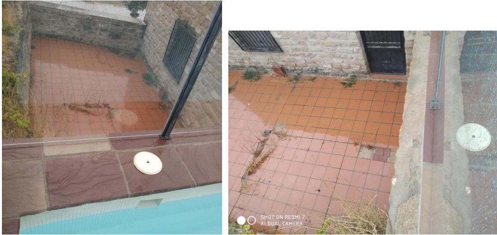
Nivel del patio de la casa vecina situada al fondo del patio, al SE.
