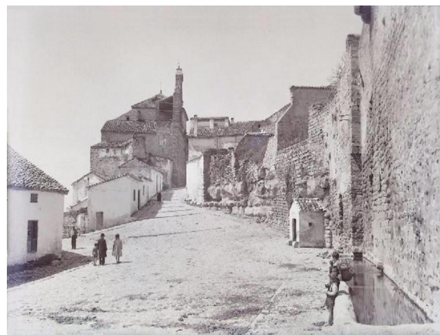
Fotografías de la calle Puerta de Granada con vista de la zona que se ha intervenido.
