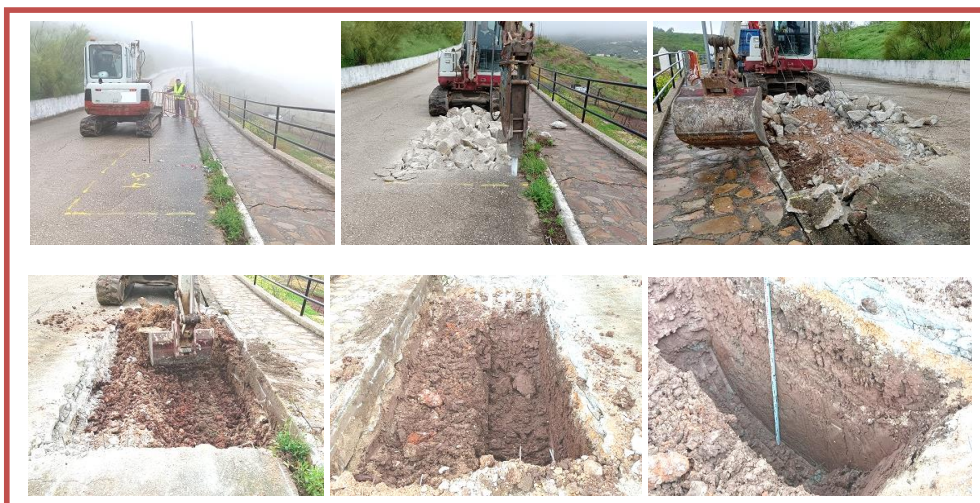
FIG. 10. IMÁGENES DEL PLANTEAMIENTO Y EJECUCIÓN DEL PROCESO DE EXCAVACIÓN, CON MEDIOS MECÁNICOS, DEL SONDEO Nº 4 EN EL DENOMINADO "SECTOR ORIENTAL" DE INTERVENCIÓN ARQUEOLÓGICA, DENTRO DEL VIAL DE LA C/. MOLINO MEDEL DE MARTOS (JAÉN). Fotos: Rafael Sánchez Susi.
