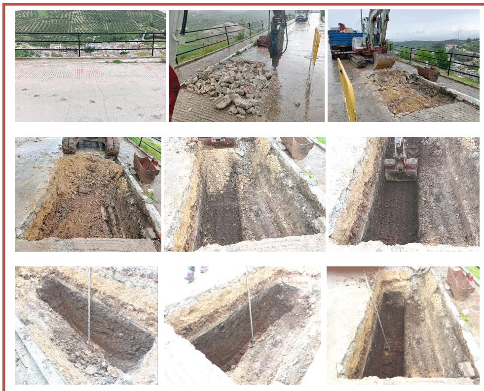
FIG. 8. IMÁGENES DEL PLANTEAMIENTO Y EJECUCIÓN DEL PROCESO DE EXCAVACIÓN, CON MEDIOS MECÁNICOS, DEL SONDEO Nº 2 EN EL DENOMINADO "SECTOR SEPTENTRIONAL" DE INTERVENCIÓN ARQUEOLÓGICA, DENTRO DEL VIAL DE LA C/. MOLINO MEDEL DE MARTOS (JAÉN). Fotos: Rafael Sánchez Susi.
