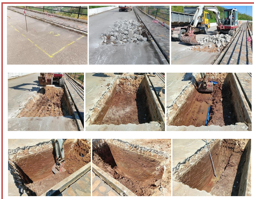
FIG. 13. IMÁGENES DEL PLANTEAMIENTO Y EJECUCIÓN DEL PROCESO DE EXCAVACIÓN, CON MEDIOS MECÁNICOS, DEL SONDEO Nº 7 EN EL DENOMINADO “SECTOR ORIENTAL” DE INTERVENCIÓN ARQUEOLÓGICA, DENTRO DEL VIAL DE LA C/. MOLINO MEDEL DE MARTOS (JAÉN). Fotos: Rafael Sánchez Susi.
