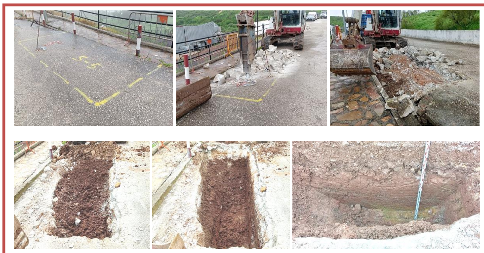
FIG. 11. IMÁGENES DEL PLANTEAMIENTO Y EJECUCIÓN DEL PROCESO DE EXCAVACIÓN, CON MEDIOS MECÁNICOS, DEL SONDEO Nº 5 EN EL DENOMINADO "SECTOR ORIENTAL" DE INTERVENCIÓN ARQUEOLÓGICA, DENTRO DEL VIAL DE LA C/. MOLINO MEDEL DE MARTOS (JAÉN). Fotos: Rafael Sánchez Susí.
