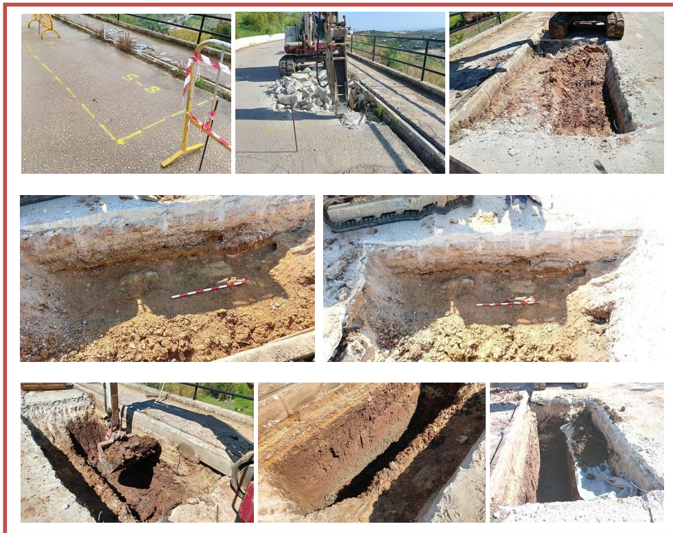
FIG. 14. IMÁGENES DEL PROCESO DE EXCAVACIÓN, CON MEDIOS MECÁNICOS, DEL SONDEO Nº 8 EN EL DENOMINADO "SECTOR ORIENTAL" DE INTERVENCIÓN ARQUEOLÓGICA. PROTECCIÓN DE LOS RESTOS EN MAL ESTADO DE CONSERVACIÓN DE UNA CONDUCCIÓN DE AGUA POTABLE DEL SIGLO XVIII (Fotos: Rafael Sánchez Susi).
