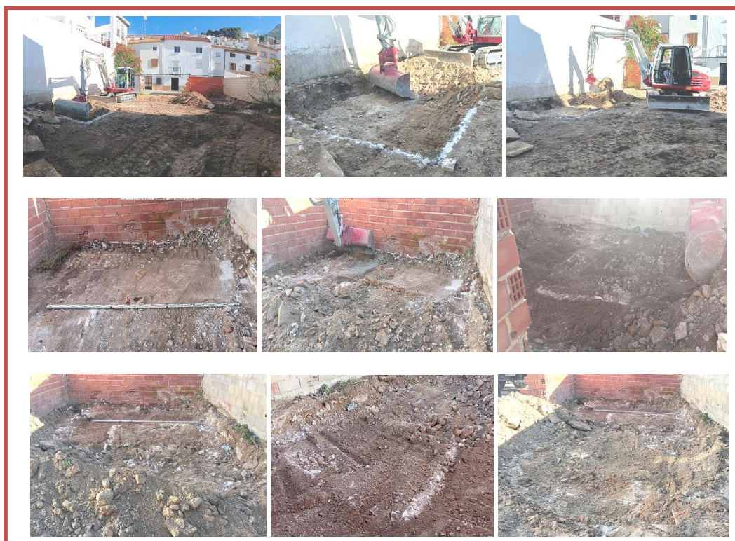
FIG. 9. ARRIBA: VACIADOS A COTA -0,60 M. DE LA ESQUINA NOROCCIDENTAL DEL ÁREA ORIENTAL DEL SOLAR DESTINADA A LA CONSTRUCCIÓN DEL NUEVO EDIFICIO PROYECTADO; CENTRO Y ABAJO: VACIADO DEL ÁREA SURORIENTAL DE ESA MITAD ORIENTAL PARA EL EDIFICIO, CON RESTOS SUPERFICIALES PARCIALES DE SOLERÍAS DE BALDOSAS DE BARRO COCIDO Y DE LOSAS DE ARENISCA Y BAJO ELLAS LAS MARCAS EN YESO POSIBLEMENTE DE LOS LÍMITES DEL ZAGUÁN DEL ANTIGUO HOTEL "IMPERIO" QUE OCUPÓ DESDE FINALES DEL SIGLO XIX ESTE ESPACIO (Fotos: Rafael Sánchez Susi).
