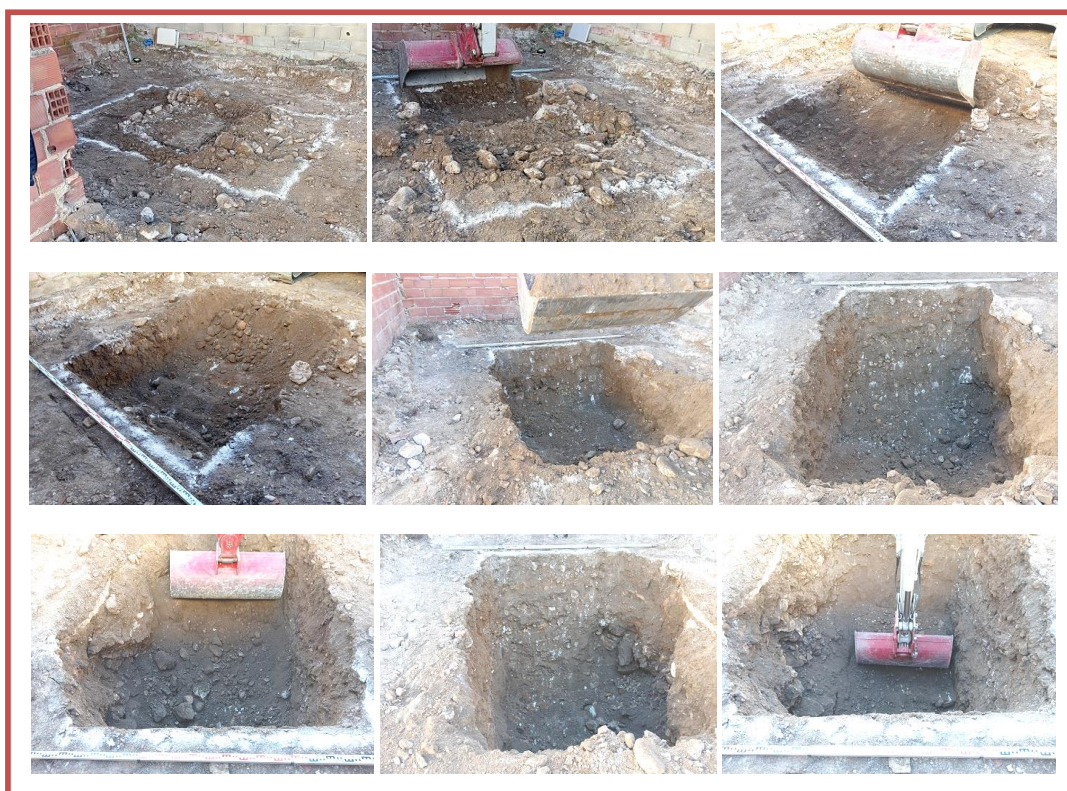
FIG. 13. PROCESO DE EJECUCIÓN, CON MEDIOS MECÁNICOS, DEL SONDEO ARQUEOLÓGICO Nº 1, EN LA ZONA SURORIENTAL DEL SOLAR, PARA LA CONSTRUCCIÓN DEL NUEVO EDIFICIO PROYECTADO (Fotos de Rafael Sánchez Susi).
