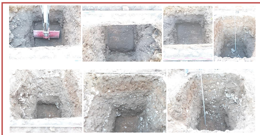
FIG. 13. PROCESO DE EJECUCIÓN, CON MEDIOS MECÁNICOS, DEL SONDEOS ARQUEOLÓGICO Nº 1, EN LA ZONA SURORIENTAL DEL SOLAR, PARA LA CONSTRUCCIÓN DEL NUEVO EDIFICIO PROYECTADO (Fotos de Rafael Sánchez Susi).
