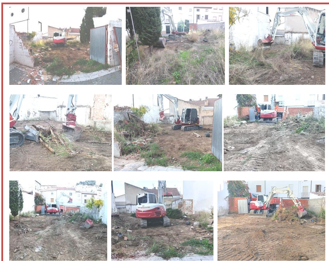
FIG. 8. IMÁGENES DEL DESBROCE SUPERFICIAL DEL SOLAR REALIZADO EL MISMO DÍA 28/12/2023 (Fotos: Rafael Sánchez Susi).
