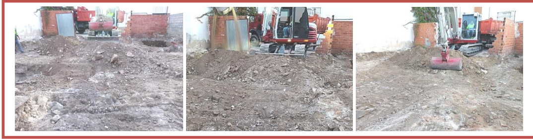
FIG. 15. ÚLTIMOS TRABAJOS DE NUESTRO CONTROL ARQUEOLÓGICO DE MOVIMIENTOS DE TIERRAS: TERMINACIÓN DEL REBAJE ARTIFICIAL DE -0,50/-0,60 M. EN LA ZONA DESTINADA A LA CONSTRUCCIÓN DEL NUEVO EDIFICIO PROYECTADO, DEJANDO UNA PEQUEÑA RAMPA DE ACCESO AL SOLAR EN EL INTERIOR DE LA LÍNEA DE FACHADA (Fotos de Rafael Sánchez Susi).
