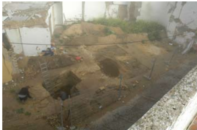
Figura 2. Vista general de la excavación
