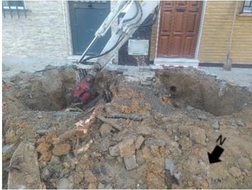
Lámina 4 Detalle apertura nuevas arquetas y zanja principal
