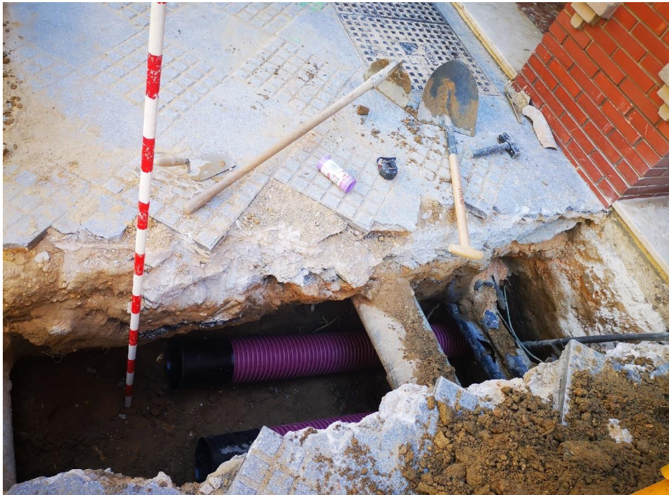
Fig. 6. Tramo de la zanja finalizado para introducir los tubos para la electricidad.
