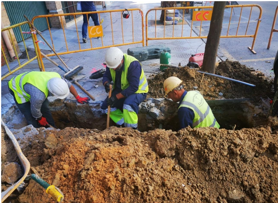
Fig. 3. Comienzo de los trabajos en la calle Paseo de la Independencia. Apertura de la zanja que se dirige hacia la primera arqueta.
