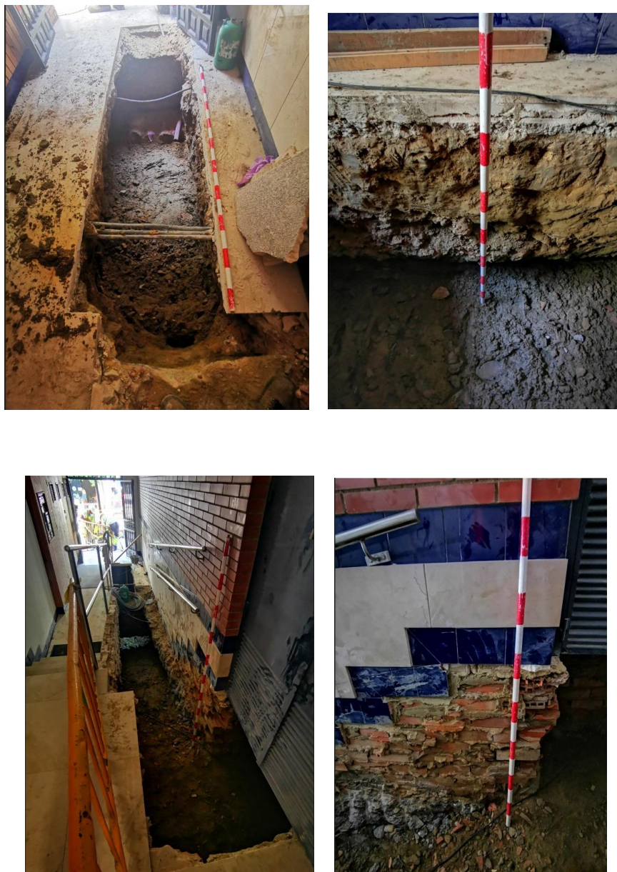
Fig.11. Fotografías con el jalón de la zanja del interior del zaguán edificio nº 8.
