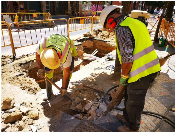
Fig.9. Apertura de la arqueta proyectada en la calzada y en la acera.
