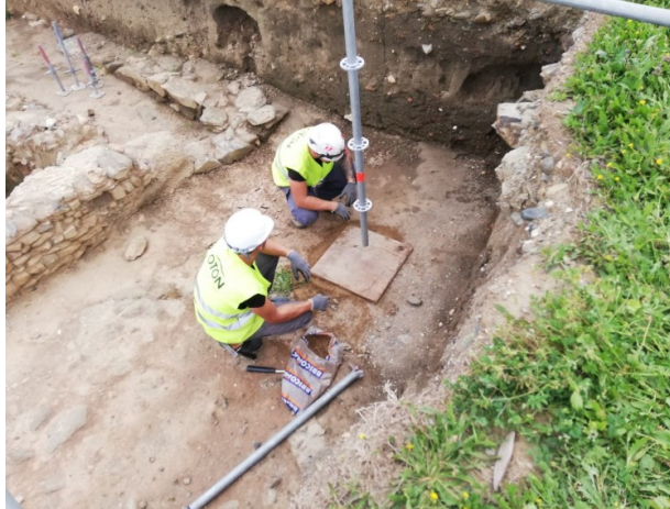
Colocación de madera y de la estructura desmontable
