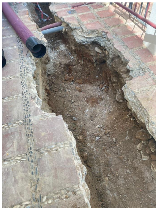
Detalle de zanja y arqueta
