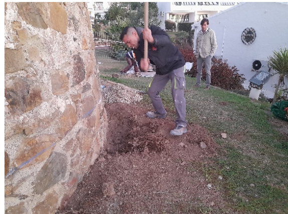
Ejecución de cajeo de 10 a 40 centímetros mediante medios manuales.
