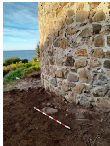
Ejecución de cajeo de 10 a 40 centímetros mediante medios manuales.
