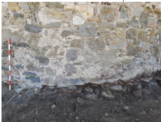
Cimentación elaborada con pequeños mampuestos
