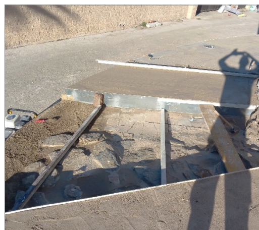
Proceso de hormigonado dejando al descubierto los restos arqueológicos
