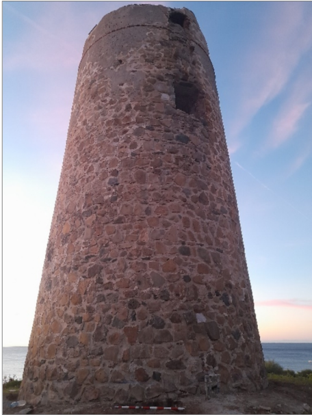
Estado previo a los movimientos de tierra
