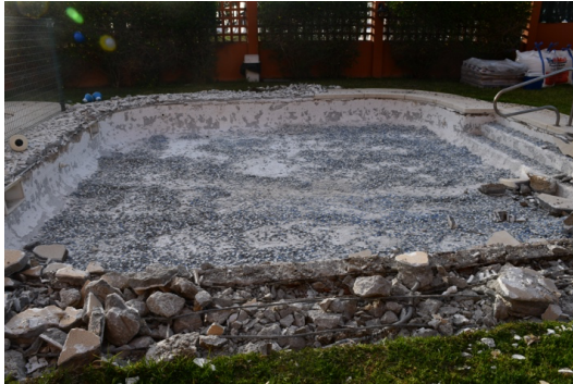
Láms. I a IV. Trabajos iniciales de levantamiento de revestimiento de la piscina.
