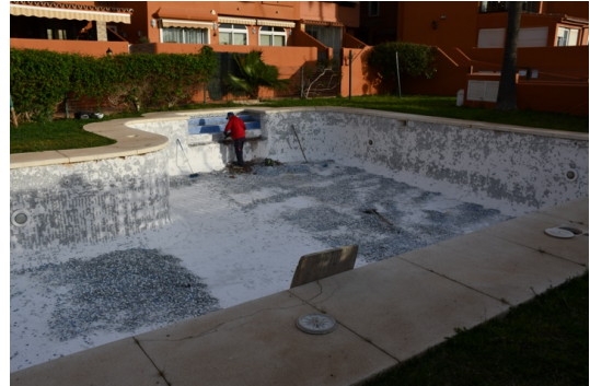
Láms. I a IV. Trabajos iniciales de levantamiento de revestimiento de la piscina.
