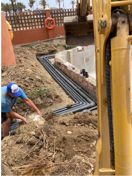
Láms. VII a IX. Retirada de tuberías originales en el perímetro de la piscina e instalación de las nuevas.
