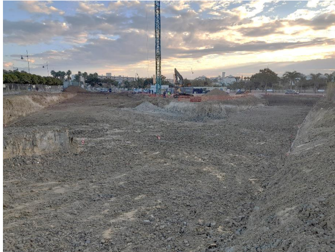
Estado final de la parcela tras los mvimientos de tierra
