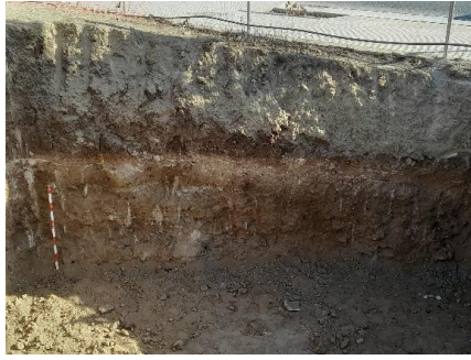
Excavación de dos catas para la instalación de grúas
