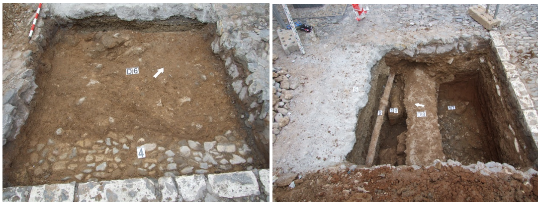
FIGURA 8. INICIO Y FINAL DEL SONDEO D
