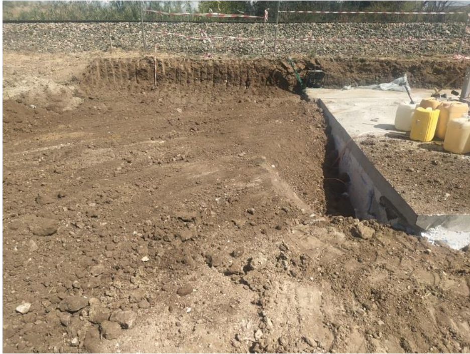
Lámina 7: explanación del terreno
