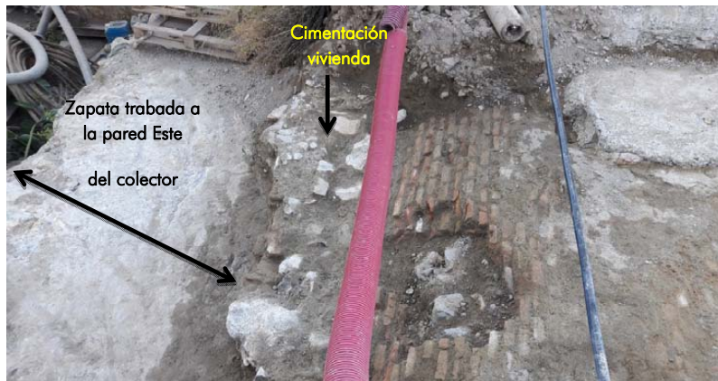
Lám 7-Vista del embovedado y pared Este del colector
