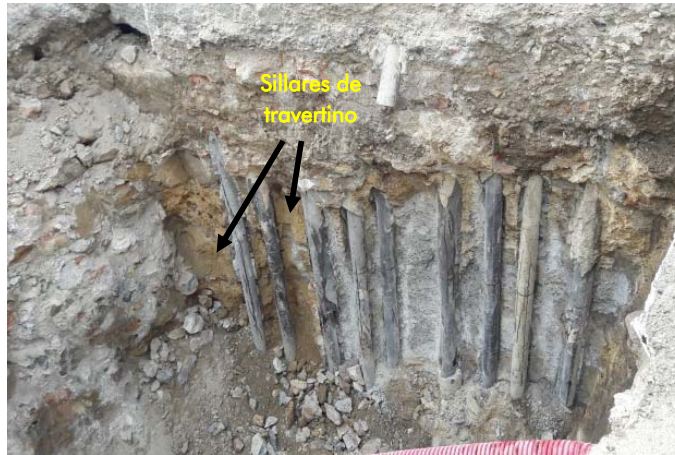
Lám. 3-detalle de los sillares de travertino y micropilotes que los rompen
