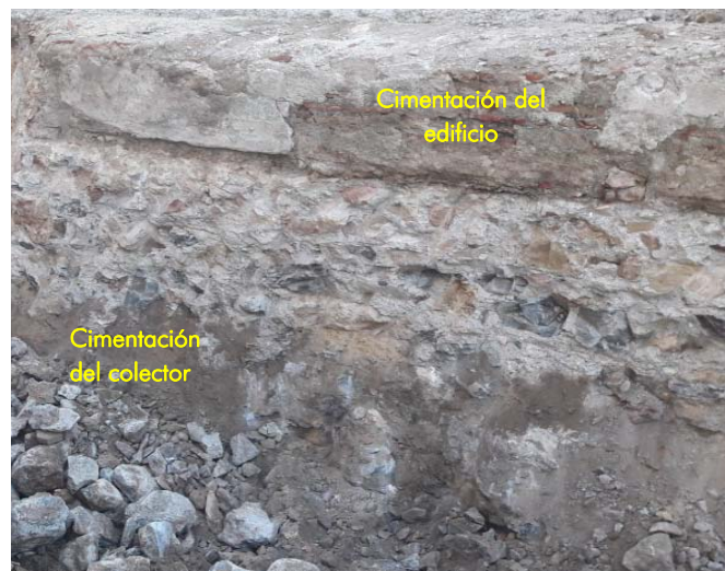
Lám. 2-Detalle de la cimentación del edificio y del colector histórico
