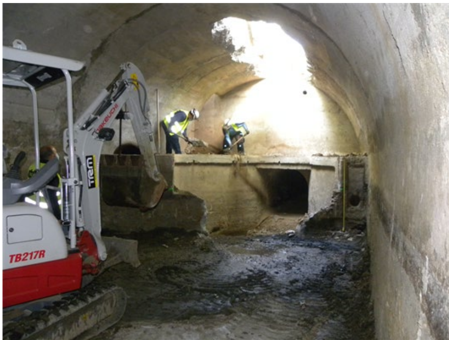
Vista de la cámara hacia el oeste
