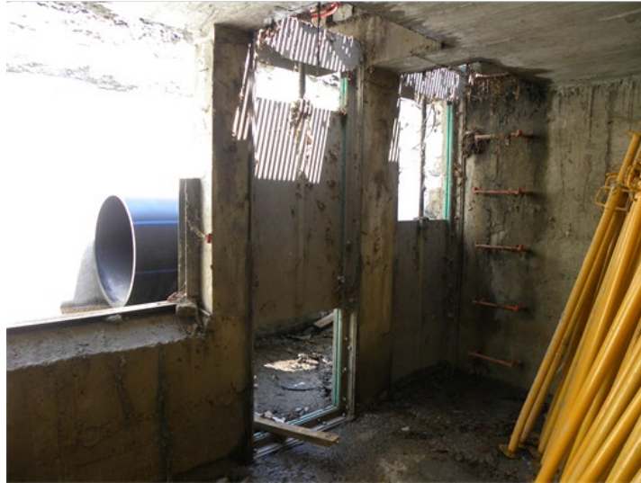
Compuertas de aliviadero
