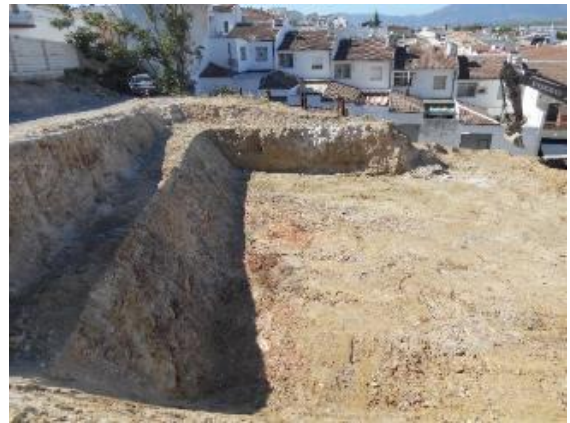
Foto 20. Planta 2. Sondeo 3. US 7, 9, 15, 11 y 16
