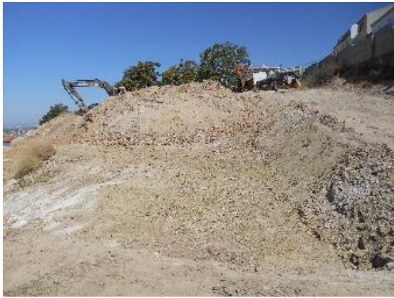
Foto 19. Planta 1. Sondeo 3. US 7 y 8
