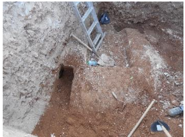
Foto 30. Planta 3. Sondeo 4. Detalle aparición de las estructuras excavadas a mano
