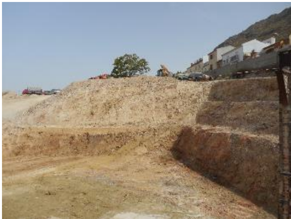
Foto 21. Planta 3. Sondeo 3. US 7, 9, 15, 22, 23 y 2
