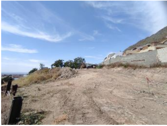
Foto 17. Planteamiento Sondeo 3 desde el sur
