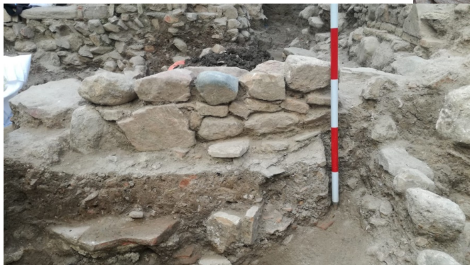
Detalle de la edificación en muro Ue. 146
