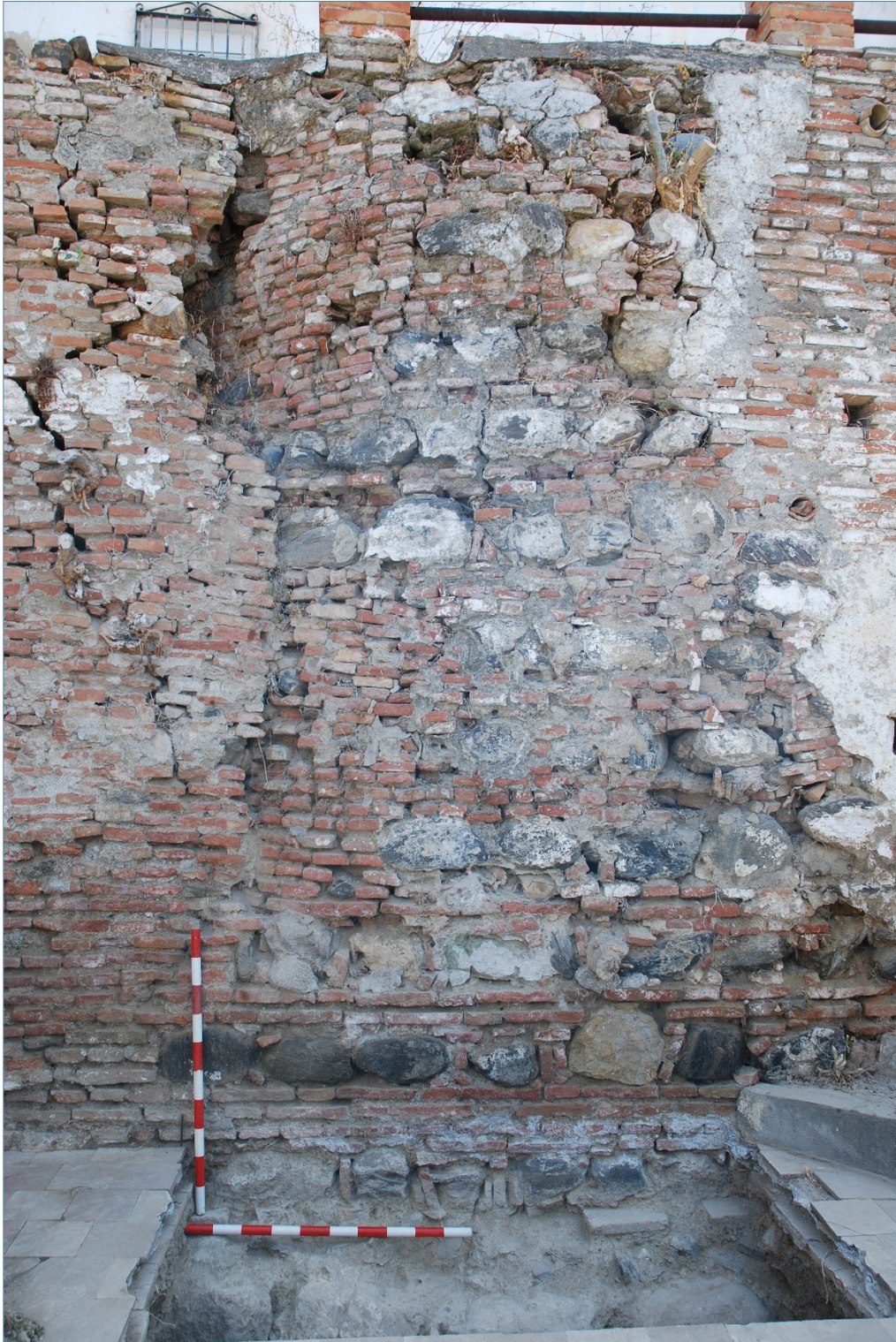
Fig. 6. Detalle del alzado de la torre, una vez finalizados los trabajos de excavación del sondeo. Se observa un cubo a modo de zócalo, así como una recia zarpa en la base de la construcción.
