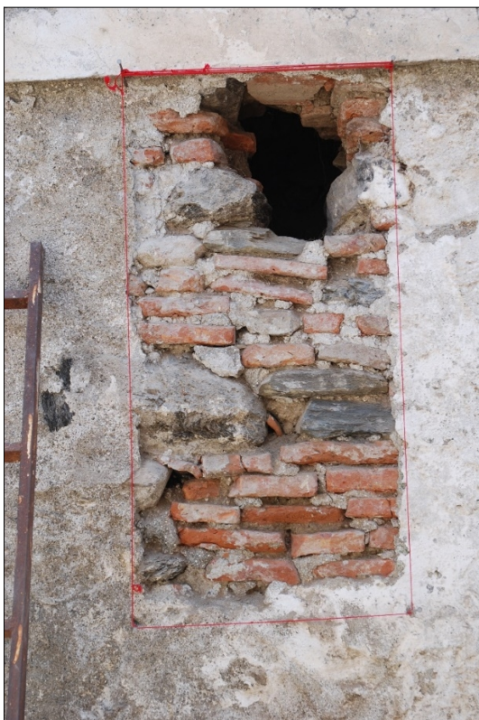
Fotografía de la izquierda, perforación del muro UEM2A aprovechando un mechinal. Fotografía inferior, al fondo de la cata, escombros que conforman los rellenos de nivelación de la terraza intermedia.
