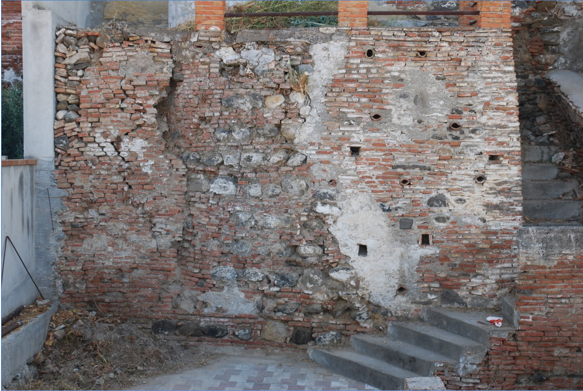
Fig. 4. Detalle del zócalo que sustenta la terraza del Sector 3, en cuyo centro se observa de manera evidente el frontis de la torre, destacando los característicos encintados de mampostería que caracterizan la edificación de las fortalezas granadinas.
