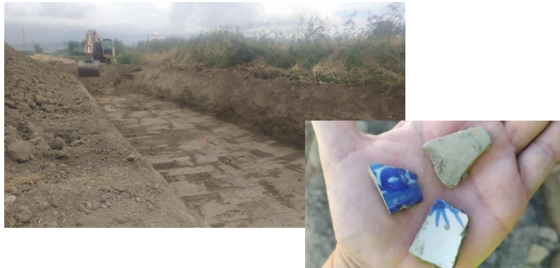
Inicio de los trabajos de ejecución de la zanja y fragmentos de cerámica documentados. Emisario Albolote-Maracena a EDAR.
