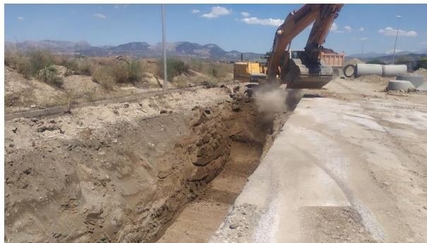
Ejecución de zanja en el Emisario Albolote-Maracena a Edar
