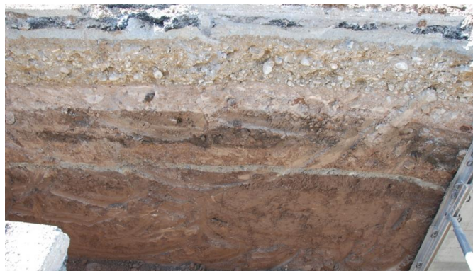
Ejecución de zanja y detalle de estratigrafía
