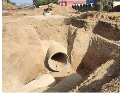
Ejecución de zanja y detalle de la estratigrafía
