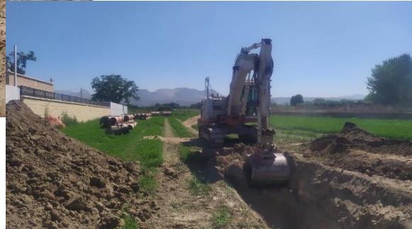
Ejecución de zanja en el Colector de Peligros
