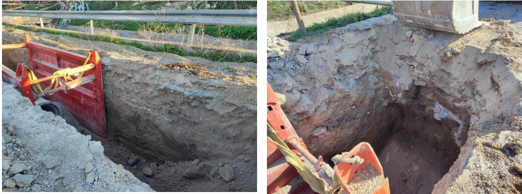
Ejecución de zanja en el Colector Maracena Sur
