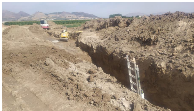
Ejecución de zanja en el Colector Maracena Sur
