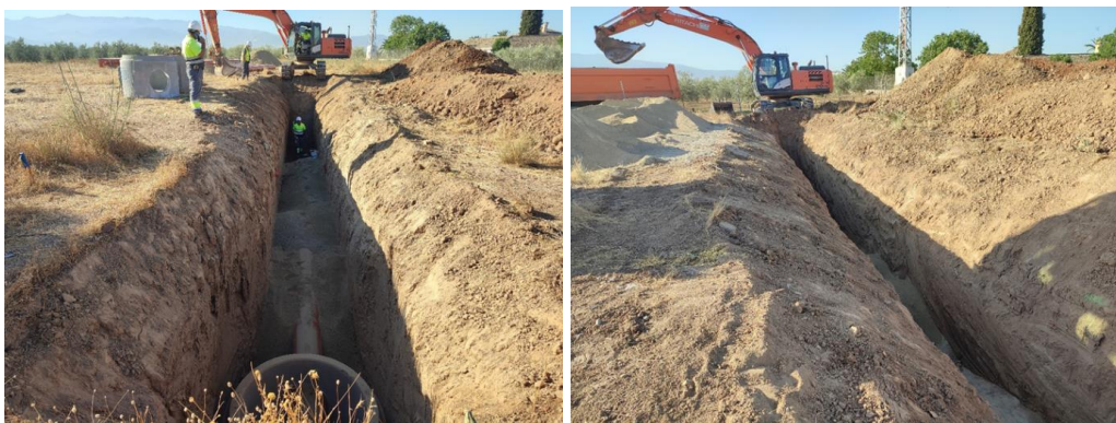
Ejecución de zanja
