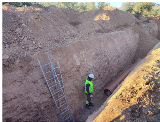
Ejecución de zanja y detalle de estratigrafía
