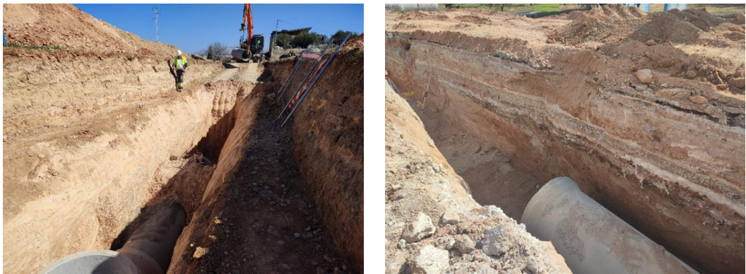
Ejecución de zanja y detalle de estratigrafía
