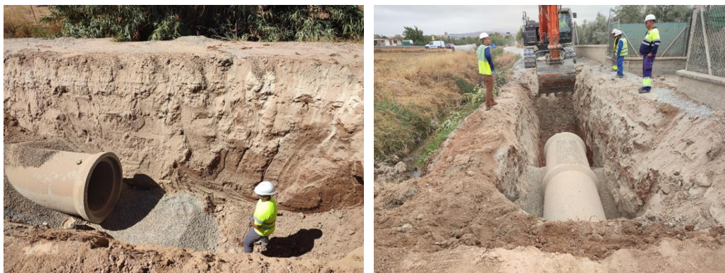
Ejecución de zanja y detalle de estratigrafía
