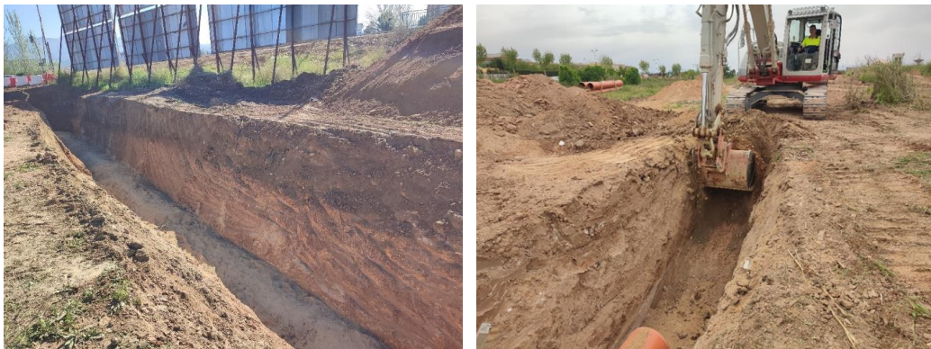
Ejecución de zanja en el Colector Maracena Pulianas I
