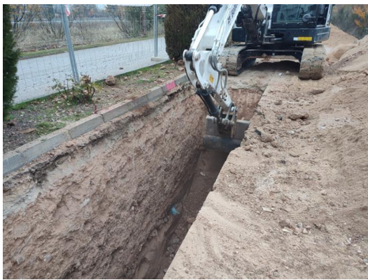
Ejecución de zanja y detalle de estratigrafía
