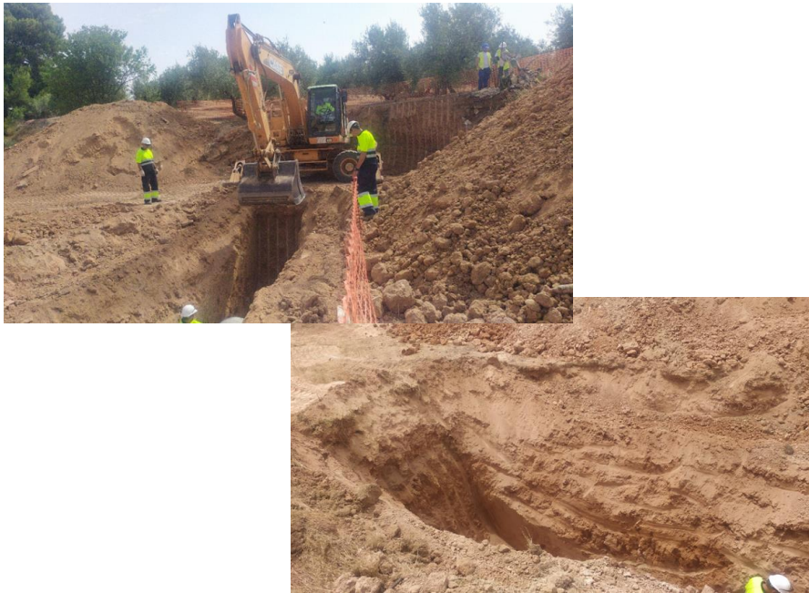
Ejecución de zanja y detalle de la estratigrafía
