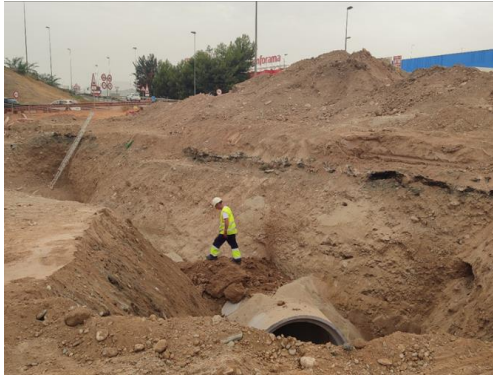
Ejecución de zanja y detalle de la estratigrafía
