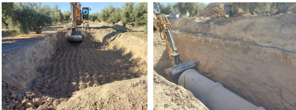
Ejecución de zanja y detalle de estratigrafía
