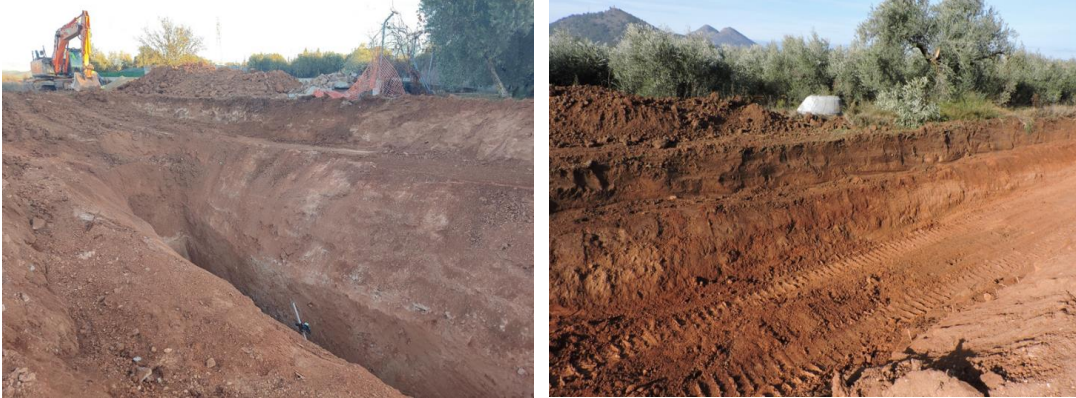
Ejecución de zanja y detalle de estratigrafía
