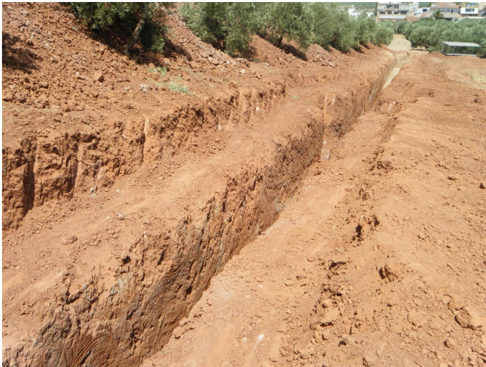
Fig. 2. Zanja en Tramo Colector A-B.
