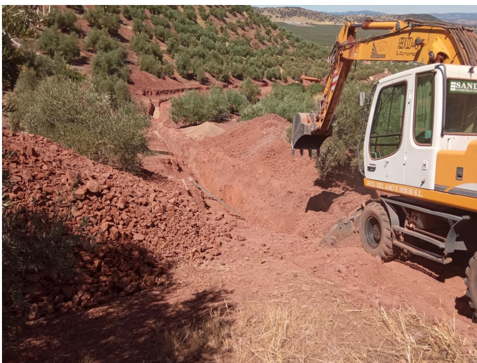
Fig. 6. Zanja en Tramo Colector F-G.
