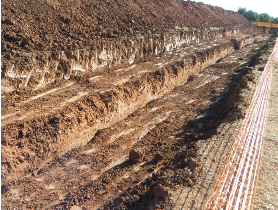
Fig. 4. Zanja en Tramo Colector B-C INICIAL.
