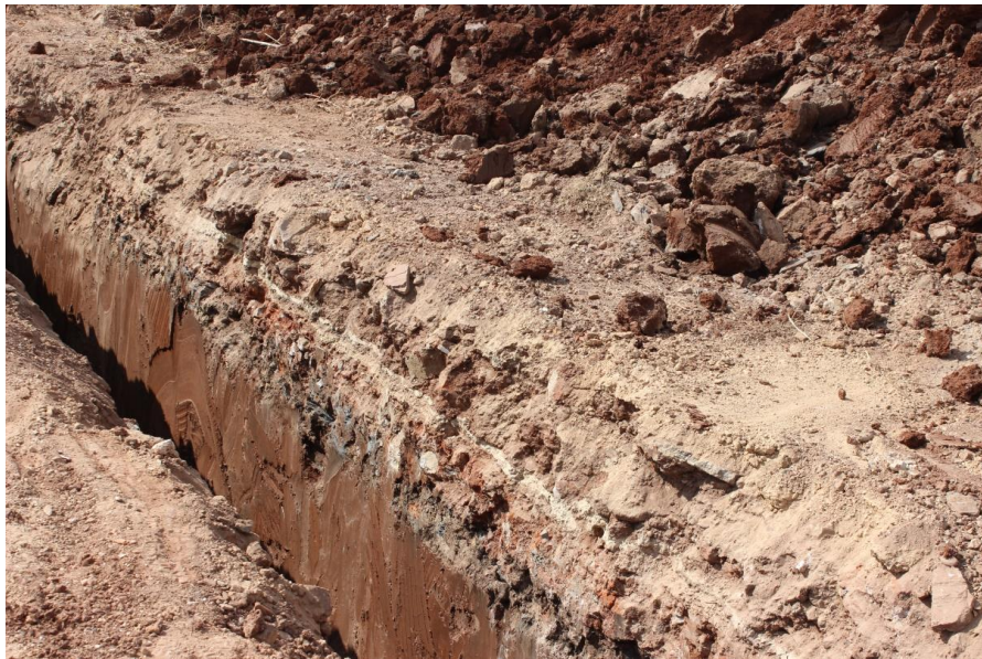
Fig. 5. Zanja en Tramo Colector B-C FINAL.
