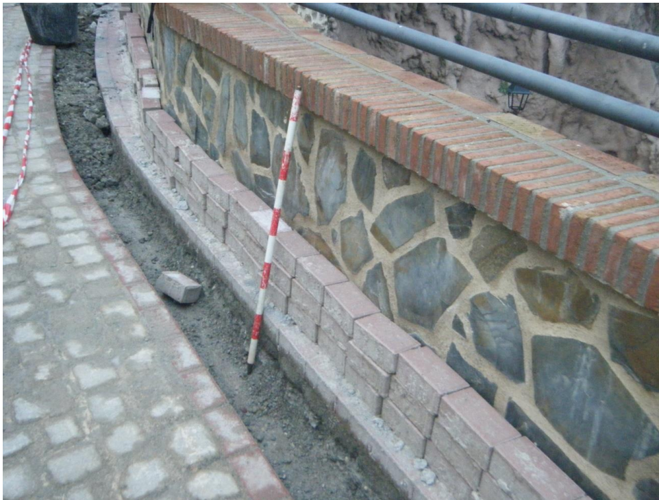
Fig. 7. Zanja en Tramo NUEVA IMPULSIÓN EN CASCO URBANO.
