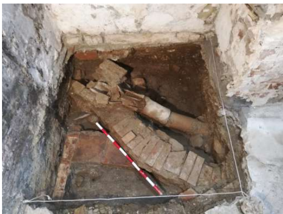
Fig. 6 Sondeo 1. Arqueta u.e. 13, tubería cerámica u.e.14, guarda de tubería de plomo u.e.17.
