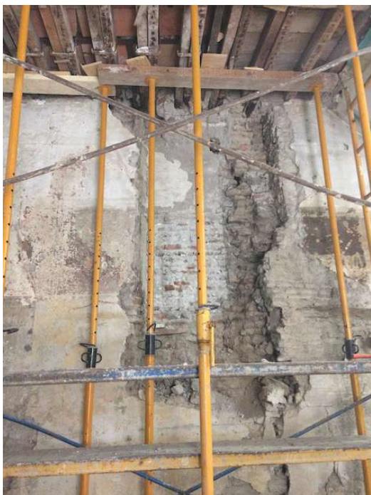
Fig. 2 Foto de trabajo durante la retirada de elementos sueltos y desprendidos.
