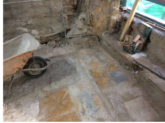
Fig. 5 Detalle u.e. 4 junto a fachada.
