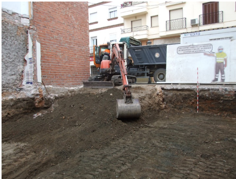
FIGURA 3. PROCESO DE REBAJE GENERAL DE LA PARCELA
