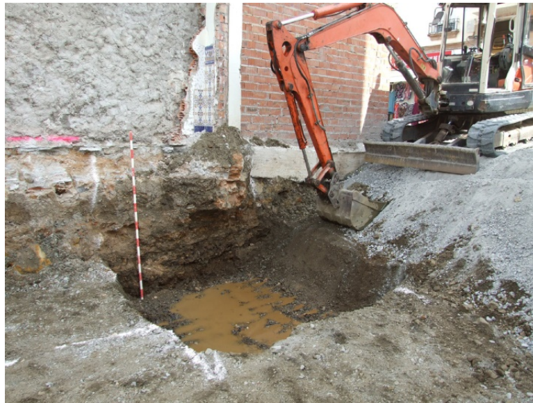
FIGURA 4. FOSO DEL ASCENSOR FINALIZADO
