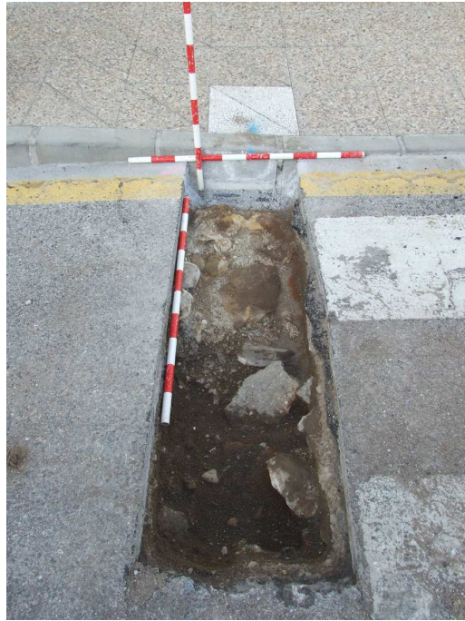
FIGURA 2. VISTA GENERAL DE MURO EN CALLE CHANQUETE
