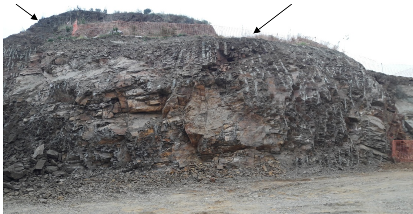
Láminas 5. Detalle de la ausencia de capa vegetal, afloramiento de geológico en superficie
