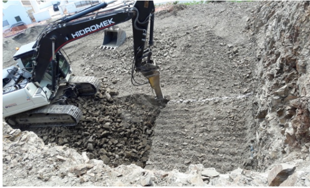
Lámina 9. Excavación de la zapata primera plataforma.
