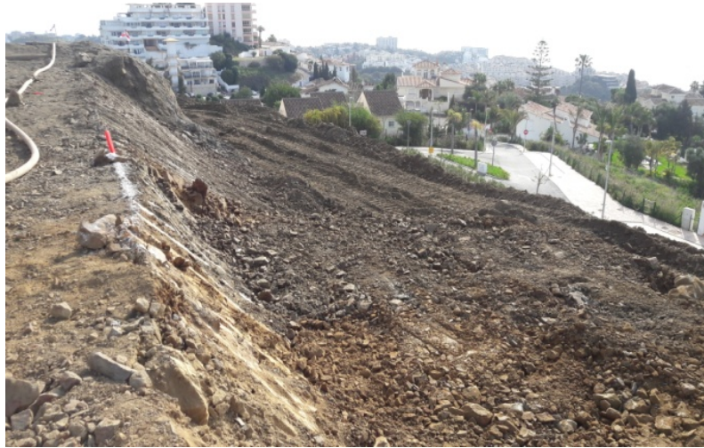
Láminas 5. Detalle de la segunda plataforma de trabajo
