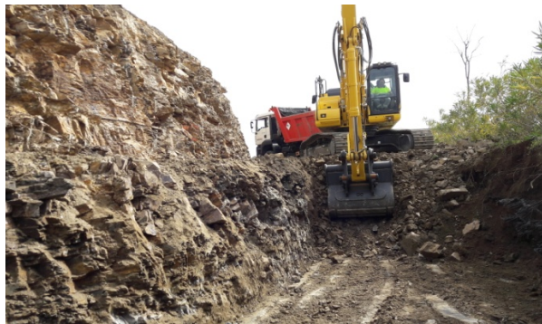
Lámina 8. Excavación de la zapata a nivel del vial de C/Pecana
