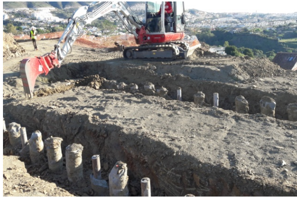
Lámina 7. Detalle de los micropilotes
