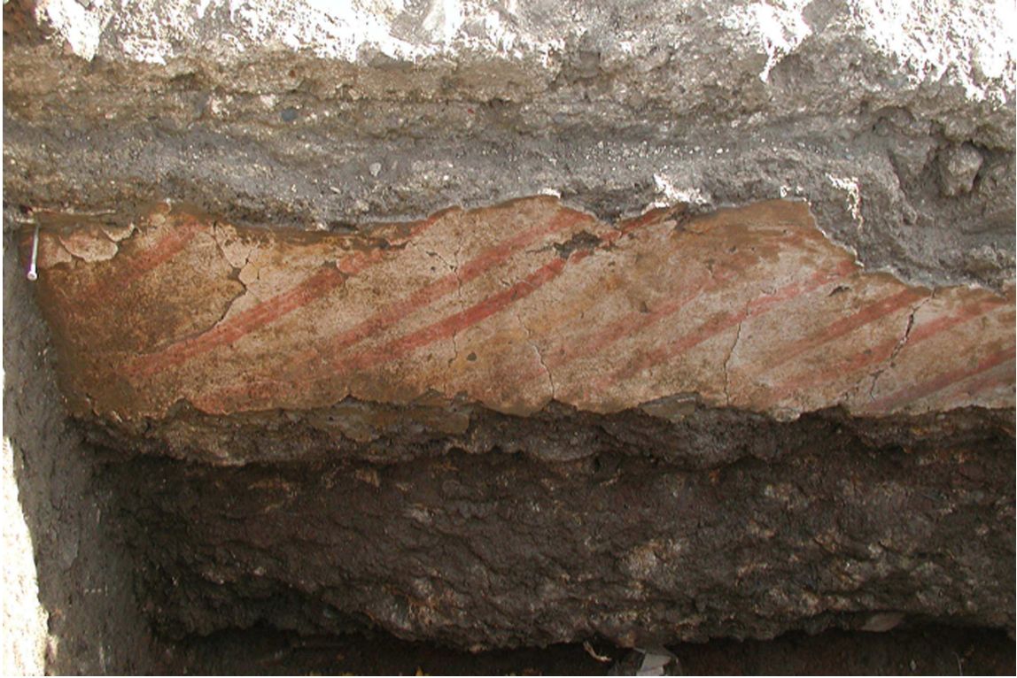
Lámina III. Detalle de la estructura de opus caementicium con restos de revestimiento de estuco policromado a bandas diagonales (U.E. 18).
