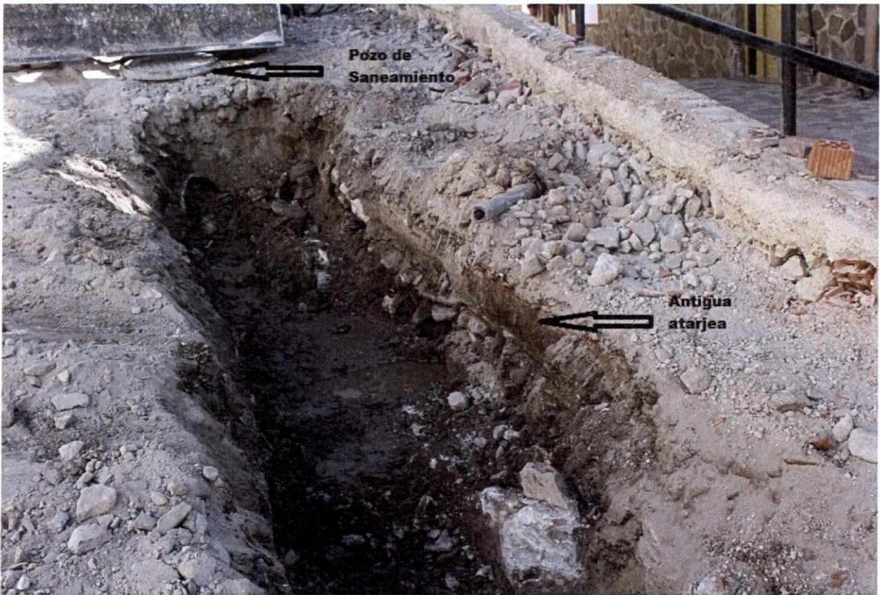
Lám. 1. Remodelaciones detectadas
