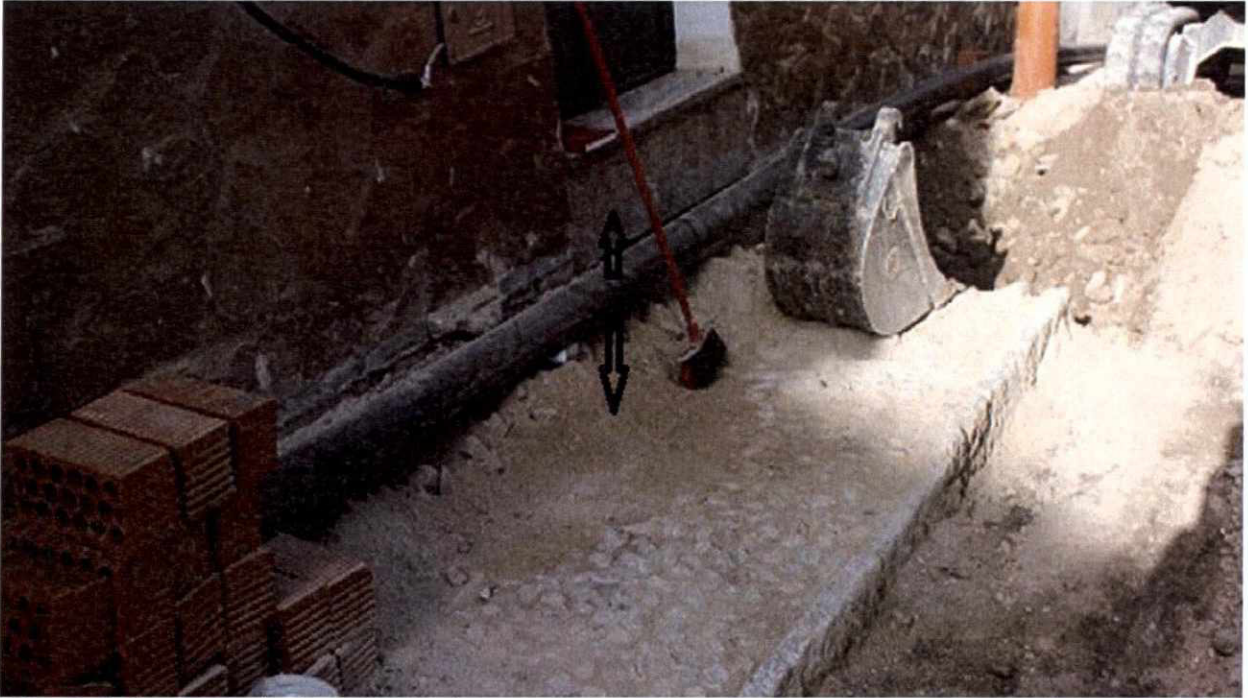
Lám. 5. Antiguo acerado de cantos de río
